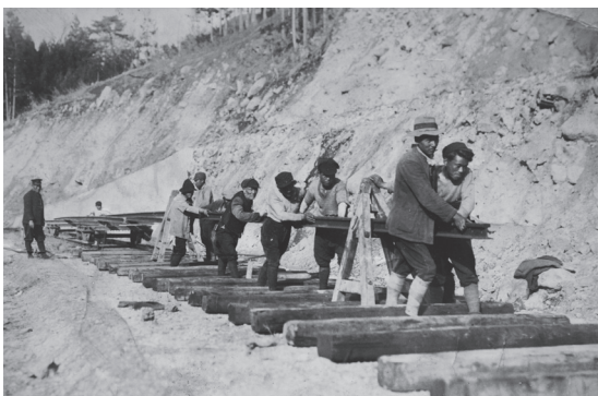
▲ 昭和16年5月 鉄道省宮下詰所、直雇人夫による線路引き延ばし (五十嵐貞子氏提供)
