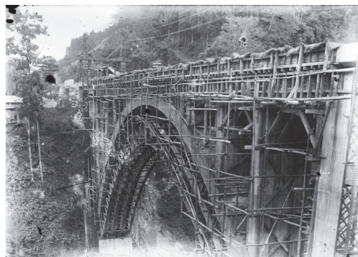
▲ 昭和14年～16年か 大谷川橋梁架設工事 (細堀貫一氏撮影)
